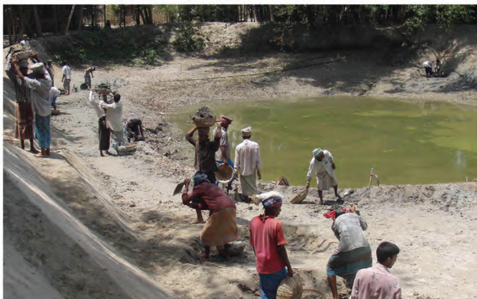
飲み水の水源とするため池の掘削
