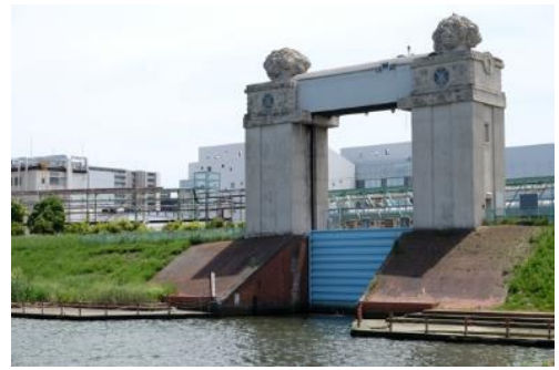
写真5 川崎河港水門
