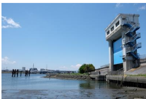
写真2 羽田第一水門
