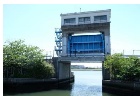
写真3 羽田第一水門裏側
