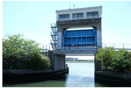
写真3 羽田第一水門裏側
