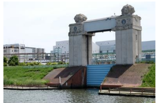
写真5 川崎河港水門
