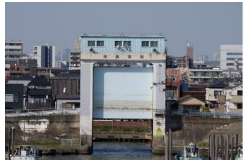
写真4 羽田第二水門
