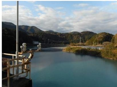
塩郷堰堤管理橋から久野脇発電所を望む。久野脇発電所で発電（78 m<sup>3</sup>/s）の後、塩郷堰堤下のサイホンから笹間川ダムに導水される。湛水は上流支川からの流入水に相当する。
