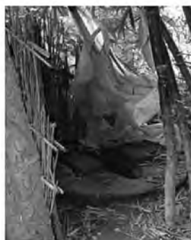
写真1 放棄された ピット・ラトリン
