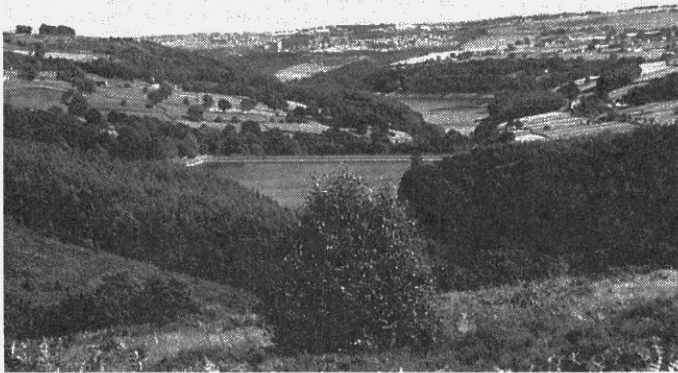
図-8. 連続する土堰堤の貯水池群
