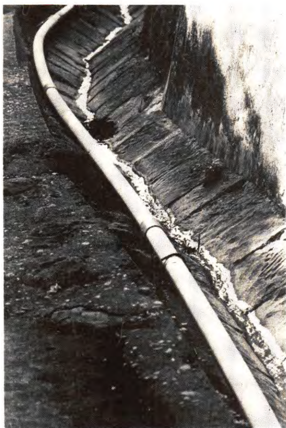
写真一 3 長崎県高島町にあるオランダ式三角溝 (写真提供、長崎市水道部・原賀欣一郎氏)
