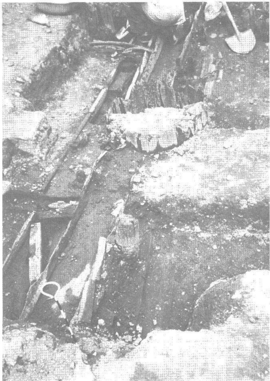
写真 浜松町のマンション建設現場 から掘り起こされた下水の遺構
