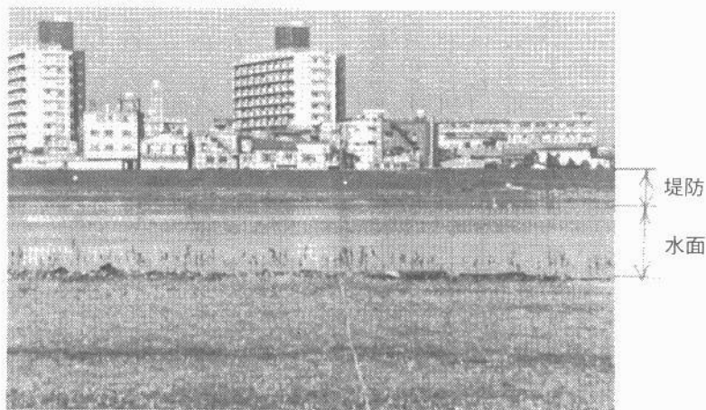
図-3 対岸の堤防の大きさと 水面の見える幅との比 R=2.2
