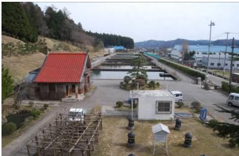
図3 三条市大崎浄水場
