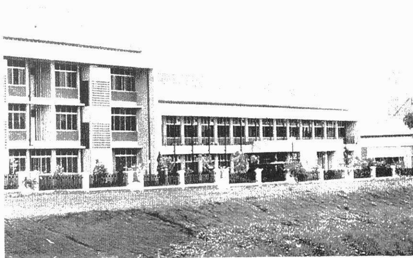
〔写10〕 ブカシ水道環境衛生訓練センター 1990年無償資金協力で設立・JICAの協力により運営
