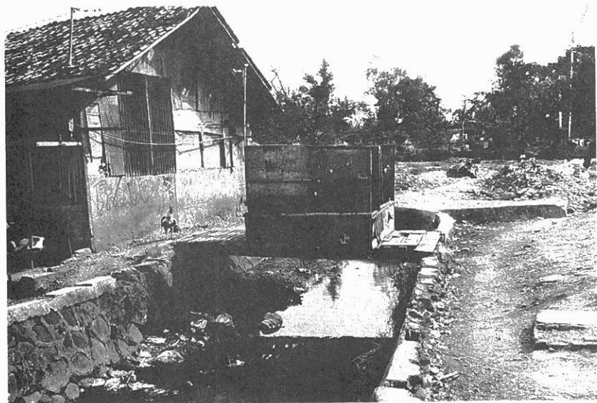
〔写 4〕 川の上に設けられたトイレ (ジャカルタ)
