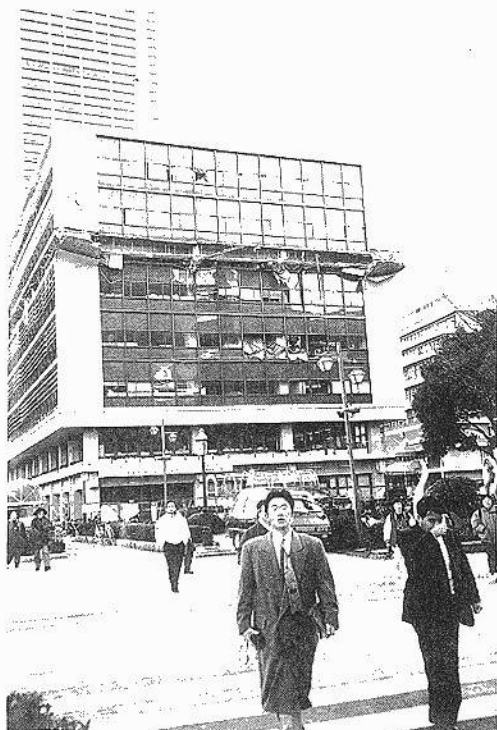
6階部分がつぶれた 神戸市役所
