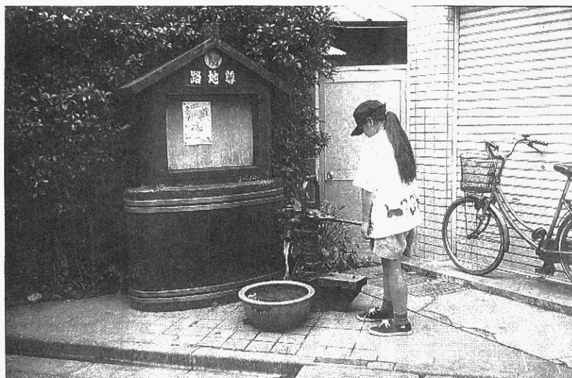
写真3 路地尊2号基 この雨水で近所のボヤを消し止めた。
