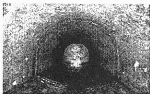
写真・2 流入渠
