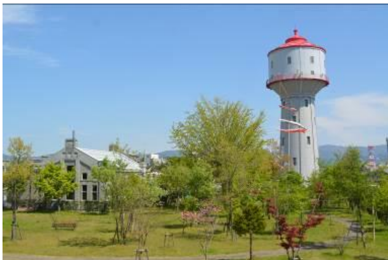
図2 向かって左側が長岡市旧中島浄水場予備発電機室棟
