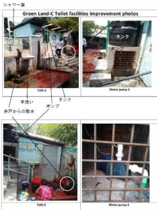
写真2 完成後の全体状況
