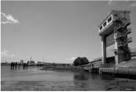
写真2 羽田第一水門
