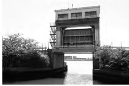
写真3 羽田第一水門裏側
