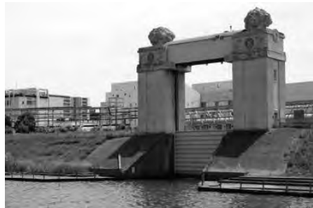
写真5 川崎河港水門
